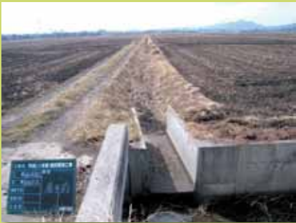
維持管理工事（南長谷京地区）
