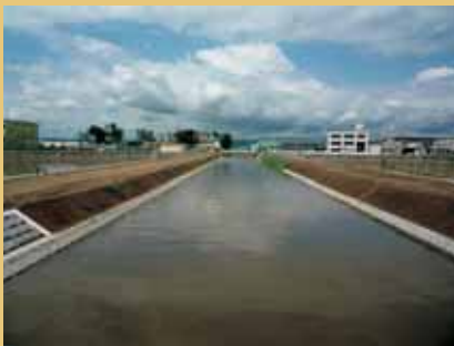
葉の木堀排水路
